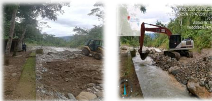
Ilustración 2. Descolmatación Bocatoma Líbano. 3/abril/2020. Fuente: Aguas Mocoa.
