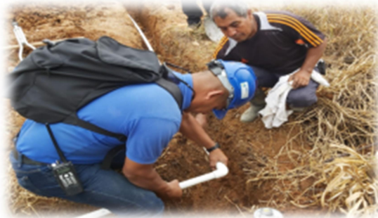
Ilustración 6. Ampliación red de Acueducto asentamiento Villa Rosa.
