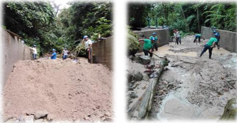
Ilustración 3. Descolmatación bocatoma Mulatico 16/04/2020
