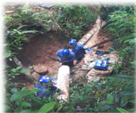
Ilustración 17. Reparación línea de 8" de Planta
