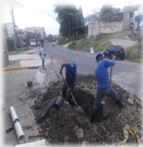
Ilustración 21. Reparación tubería de 6" La Reserva 10/06/2020
