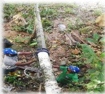
Ilustración 16. Reparación tubería de 8" de paso elevado sector la taruca
