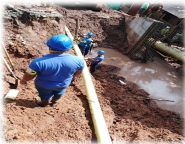
Ilustración 24. Instalación de tubería en el barrio Libertador
