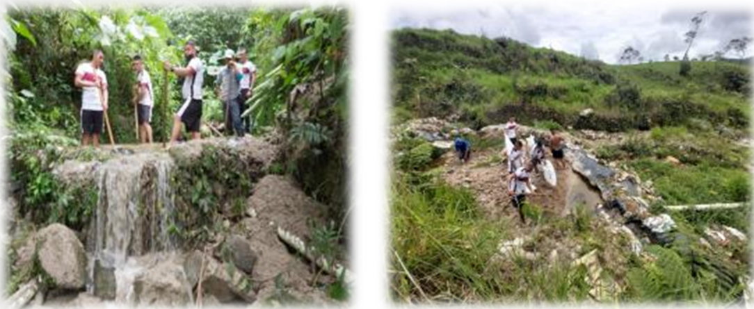
Ilustración 4. Restauración captaciones fuentes alternas 11/04/2020
