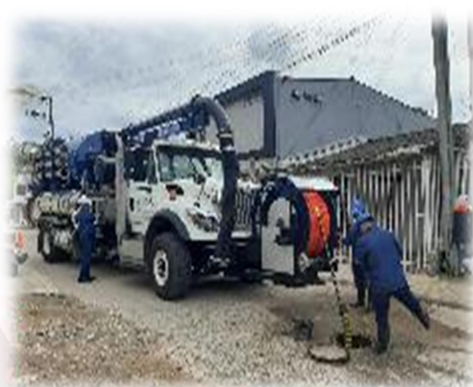
Ilustración 36. Apoyo con equipo a presión succión. Fuente Aguas Mocoa S.A. E.S.P
