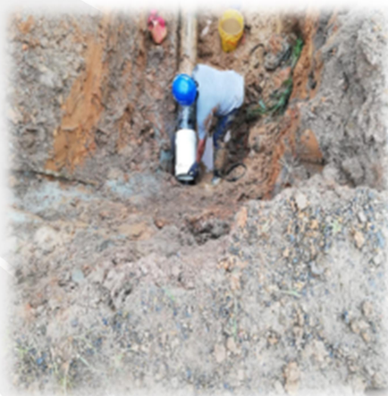
Ilustración 19. Reparación tubo de 8" en Arapaima 19/06/2020
