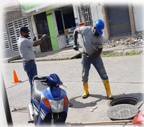
Ilustración 27. Intervención Alcantarillado Progreso 27/11/2020
