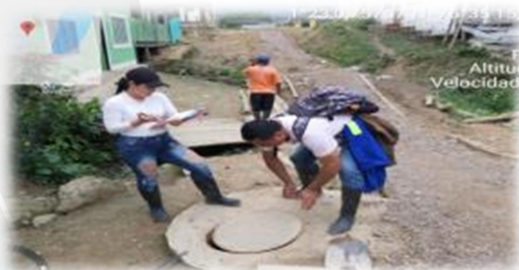
Ilustración 8. Supervisión a proyecto Alcantarillado Yunguillo 20/02/2020
