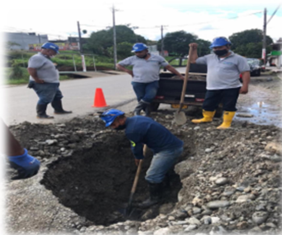
Ilustración 20. Reparación tubería de 4" de acueducto 19/06/2020
