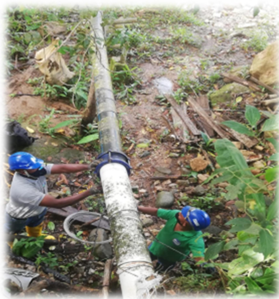
Ilustración 22. Reparación tubería de 8" de paso elevado sector la taruca 05/07/2020
