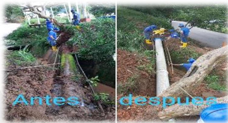
Ilustración 15. Reparación y reposición tubería de 12" la Loma 20/05/2020
