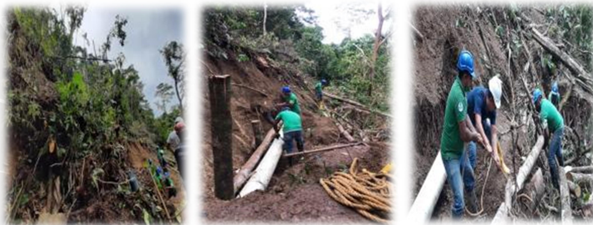
Ilustración 1. Personal operativo realizando reparación de línea de 10" de la zona norte en sector Líbano 26/07/2020
