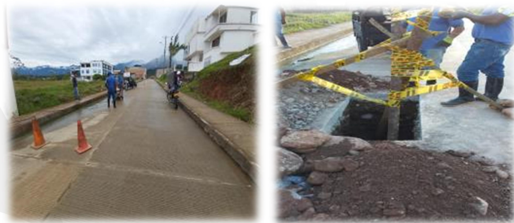
Ilustración 26. Intervención alcantarillado Ciudadela 08/08/2020
