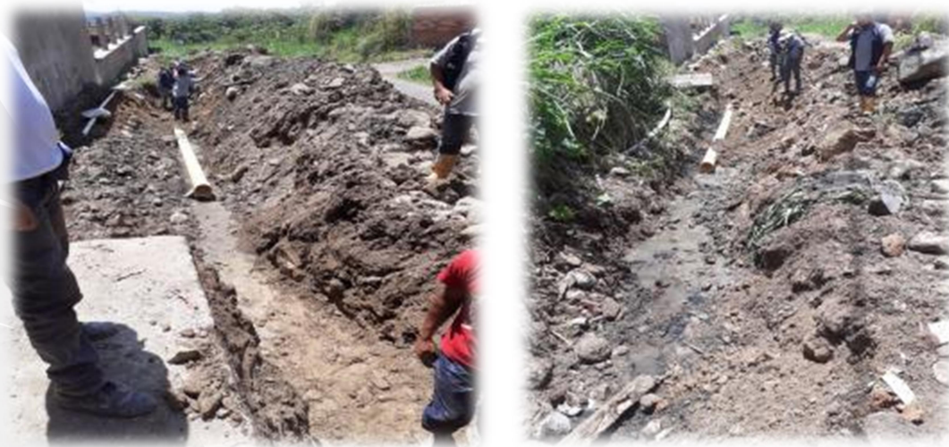
Ilustración 7. Ampliación de red de Alcantarillado Barrio los Pinos
