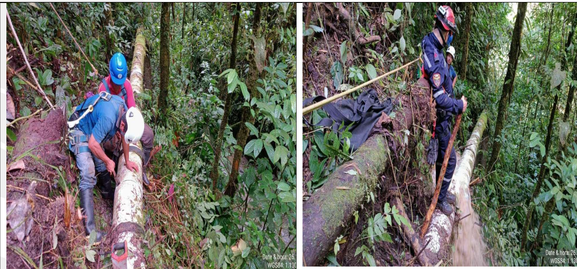
Ilustración 10: taponamiento de red de aducción chonta yaco y trabajos de des taponamiento y reparación de la misma red de aducción Fecha 27/11/23 - Fuente: Aguas Mocoa
