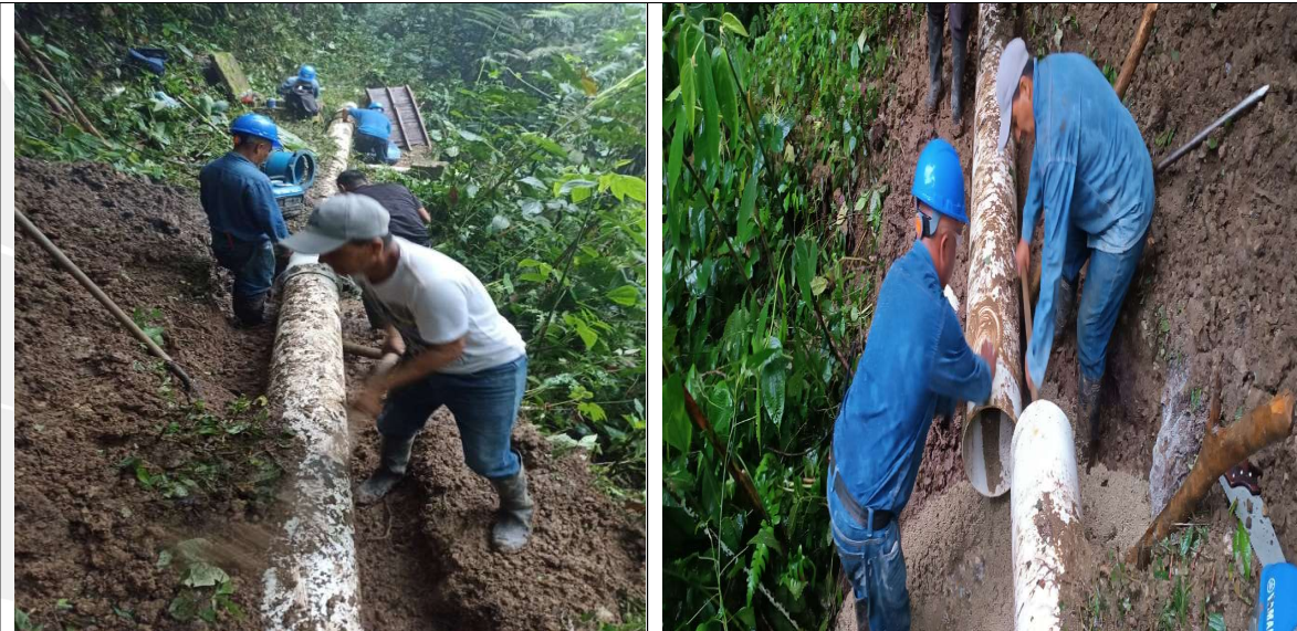
Ilustración 5: taponamiento de red de aducción chonta yaco y trabajos de des taponamiento y reparación de la misma red de aducción Fecha 27/04/23 - Fuente: Aguas Mocoa
