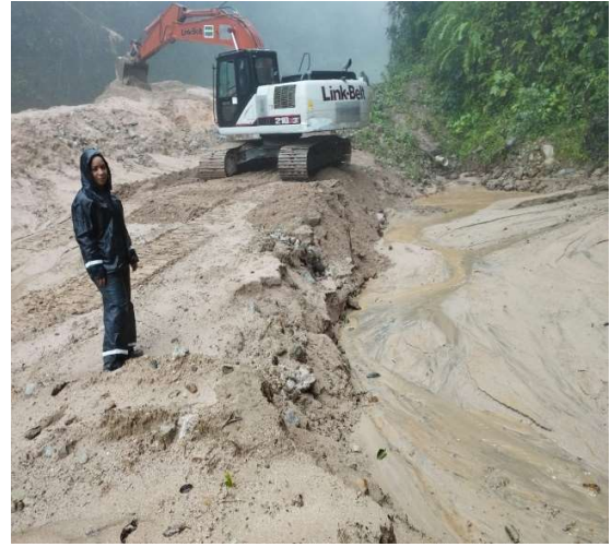
Descolmatación correctiva Bocatoma Palmeras/ Marzo 16 de 2023.
