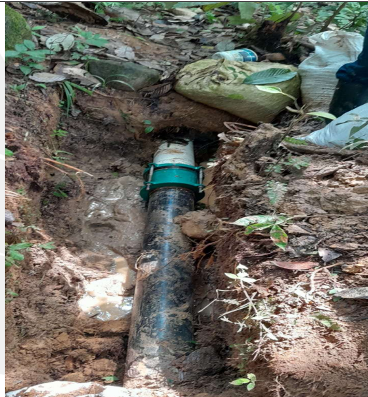
Ilustración 2: daños y reparaciones simultaneas en red de acueducto de conducción norte de 10 y 12 pulgadas instalada entre la tanque 0 y tanque 2 Fecha 22/02/23 - Fuente: Aguas Mocoa
