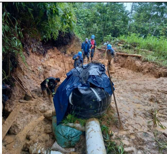
Ilustración 3: daño y reparación en red de acueducto de aducción de chonta yaco de 12 pulgadas instalada entre la bocatoma y el desarenador Fecha 11/03/23 - Fuente: Aguas Mocoa
