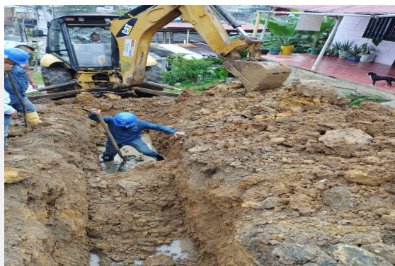
Figura 4. Actividades de destaponamiento de alcantarillado sanitario con personal operativo / B/ Quinta Paredes/14--06-2023.
