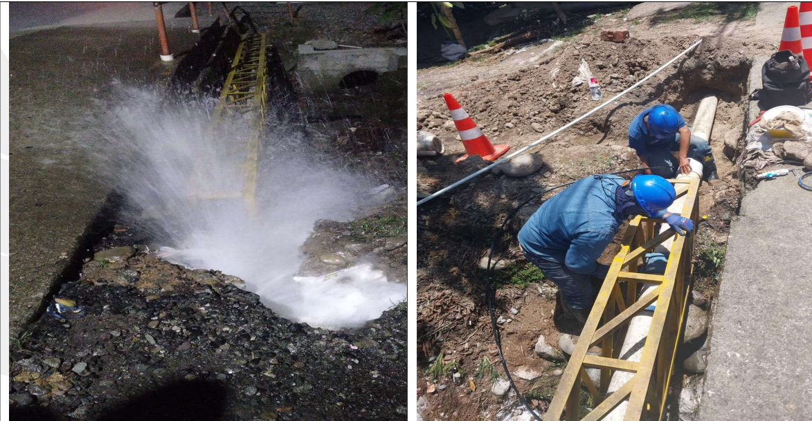
Ilustración 8: daño y reparación en red de acueducto de conducción de 6 pulgadas barrio la reserva Fecha 01/010/23 - Fuente: Aguas Mocoa
