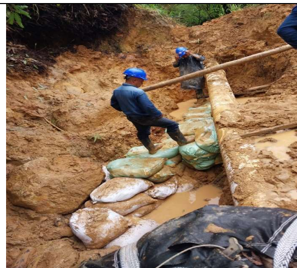
Ilustración 3: daño y reparación en red de acueducto de aducción de chonta yaco de 12 pulgadas instalada entre la bocatoma y el desarenador Fecha 11/03/23 - Fuente: Aguas Mocoa
