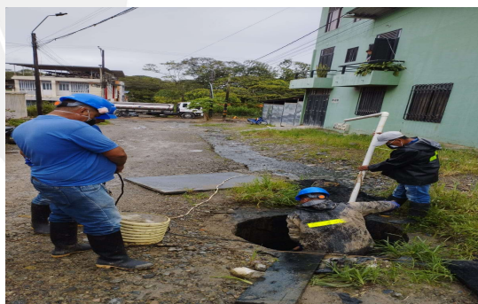
Figura 4. Actividades de destaponamiento de alcantarillado sanitario con personal operativo / B/ Quinta Paredes/14--06-2023.
