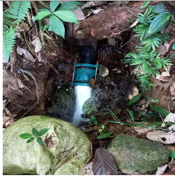
Ilustración 2: daños y reparaciones simultaneas en red de acueducto de conducción norte de 10 y 12 pulgadas instalada entre la tanque 0 y tanque 2 Fecha 22/02/23 - Fuente: Aguas Mocoa
