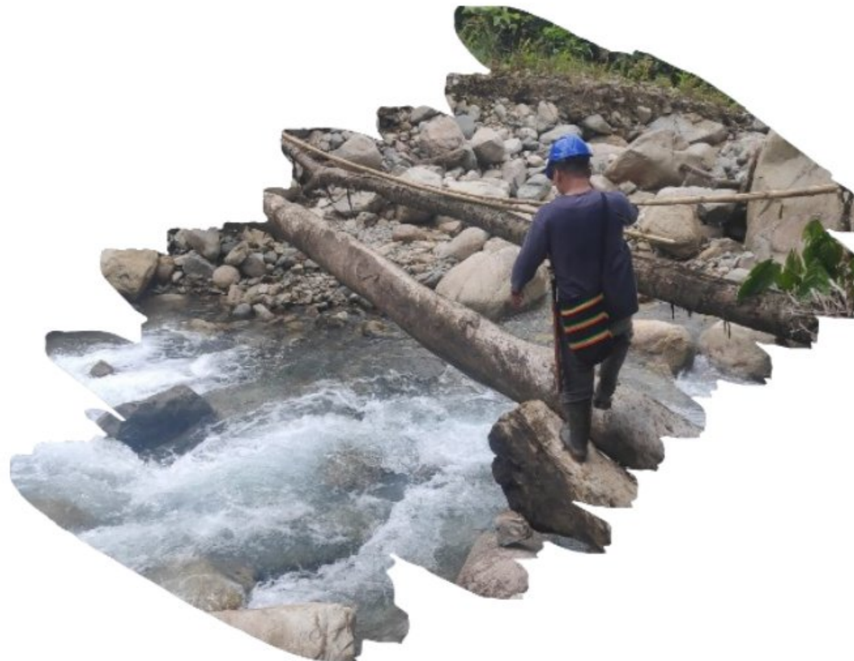
Fotografía 16. Acceso a la bocatoma Sistema Palmeras
