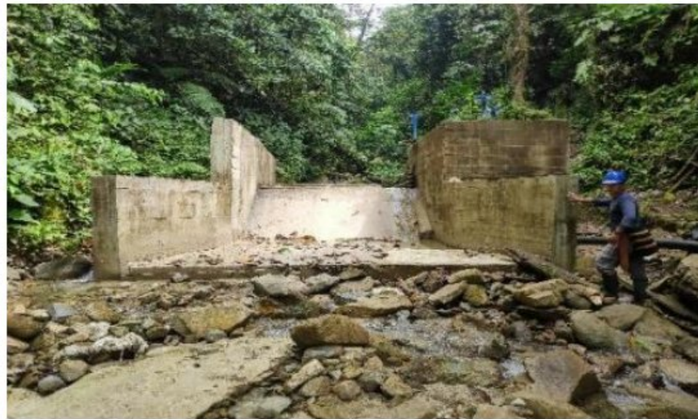
Fotografía 20. Estado de la bocatoma Q. Mulatico
