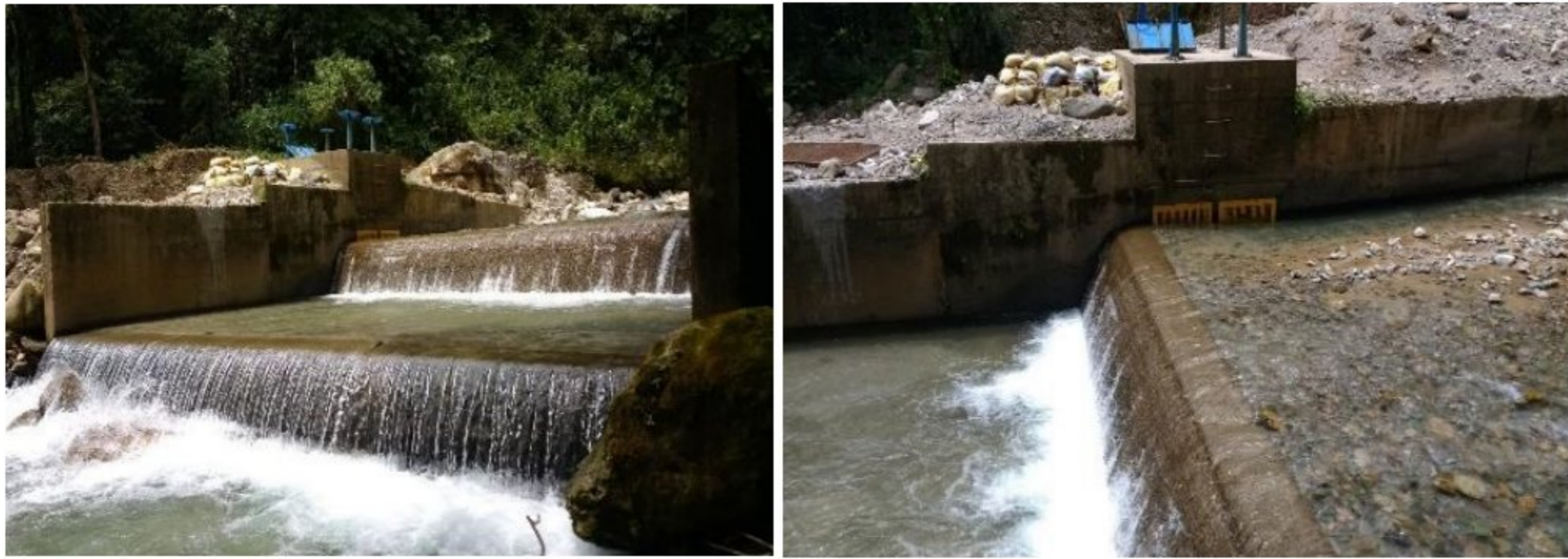
Fotografía 17. Estado actual bocatoma Sistema Palmeras
