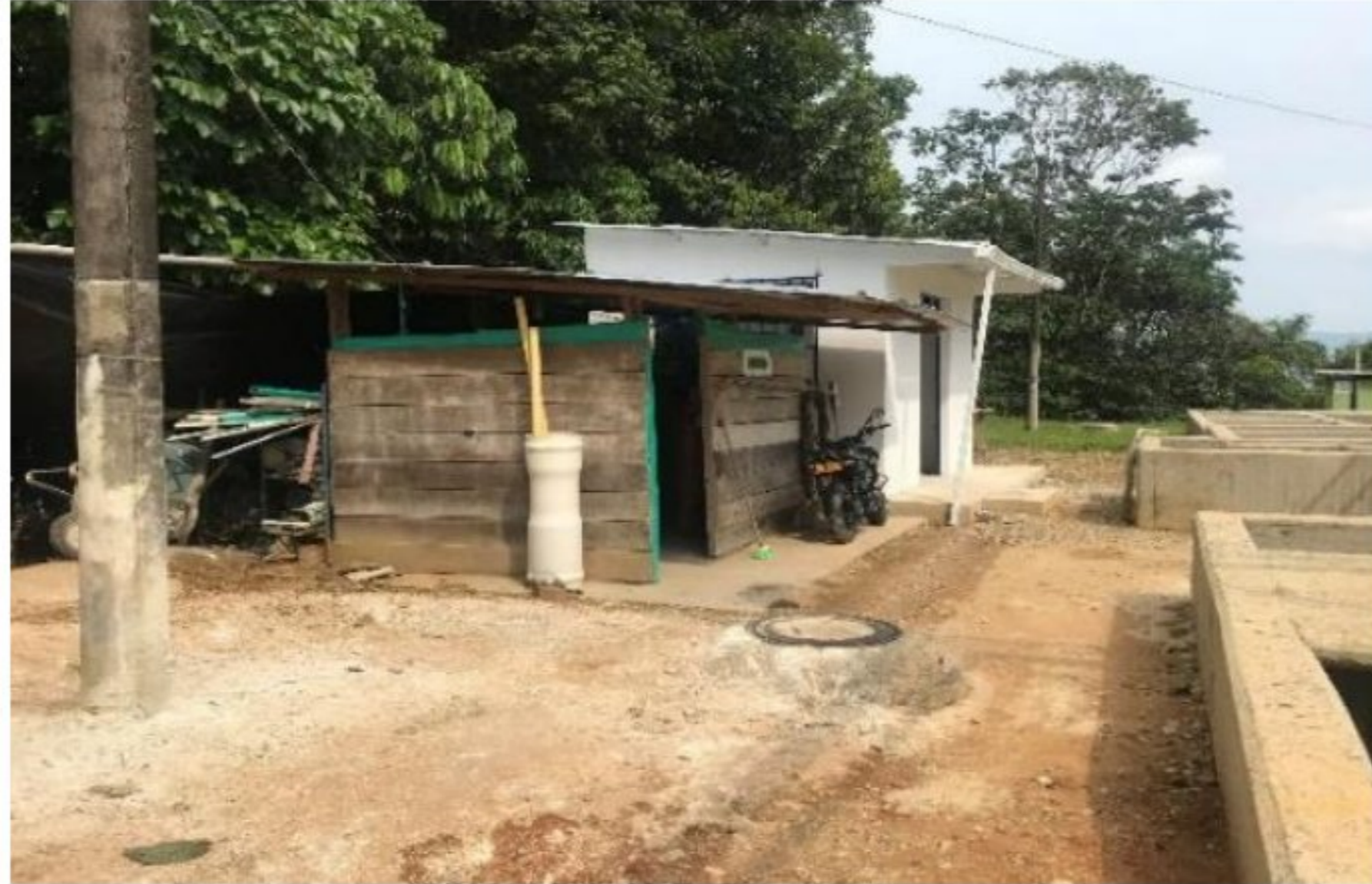
Fotografía 14. Caseta de Cloración
