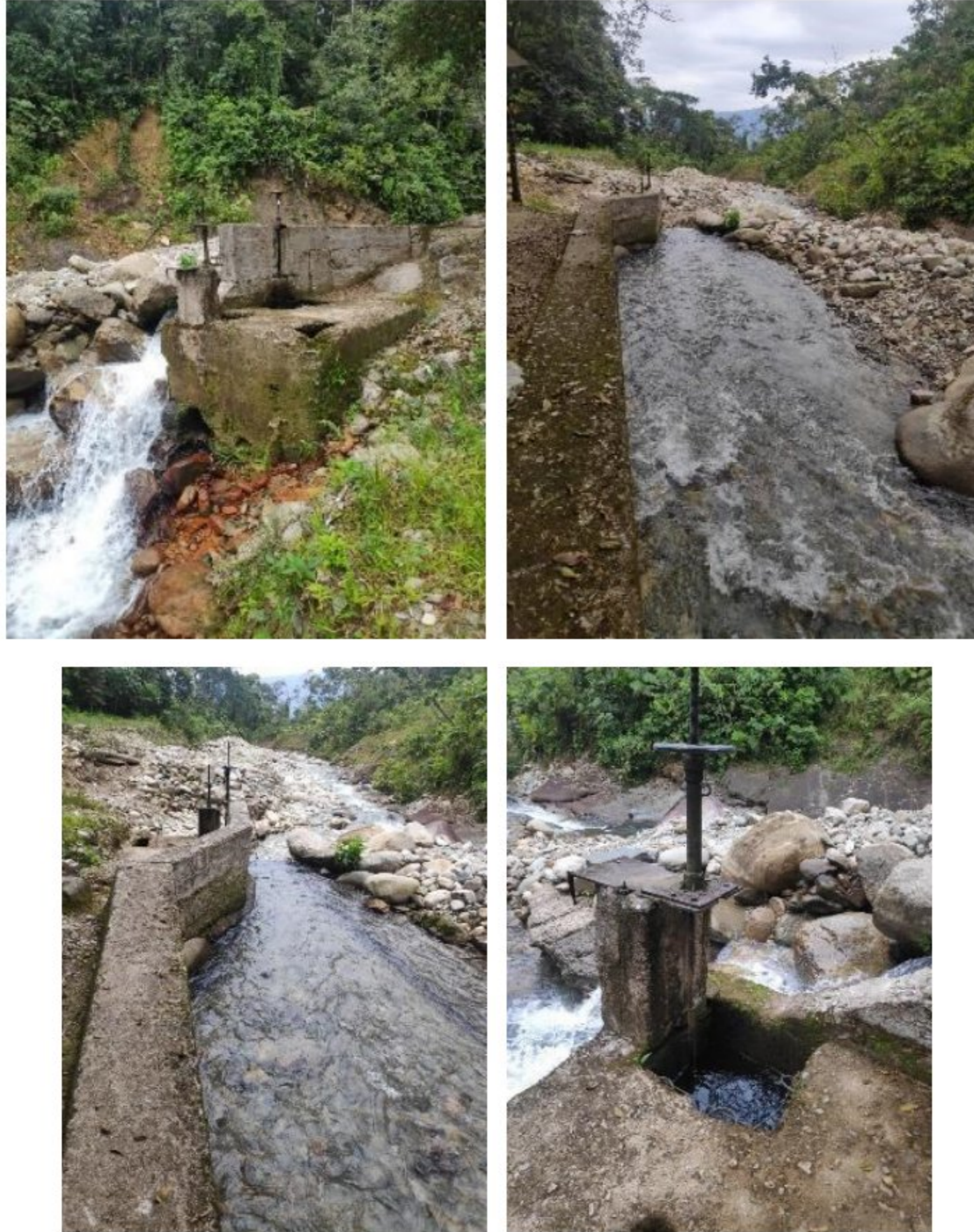
Fotografía 18. Estado de la bocatoma Sistema Líbano
