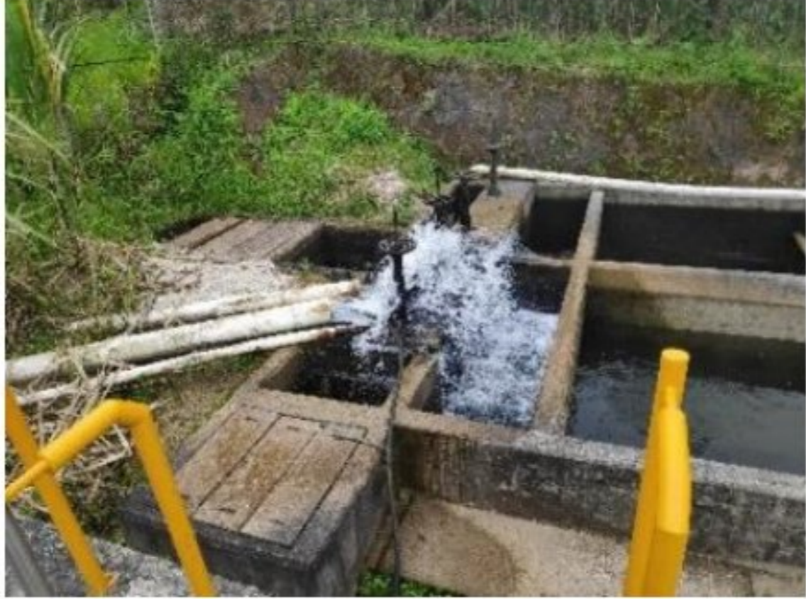
Fotografía 7. Desarenador Antigo sistema Palmeras
