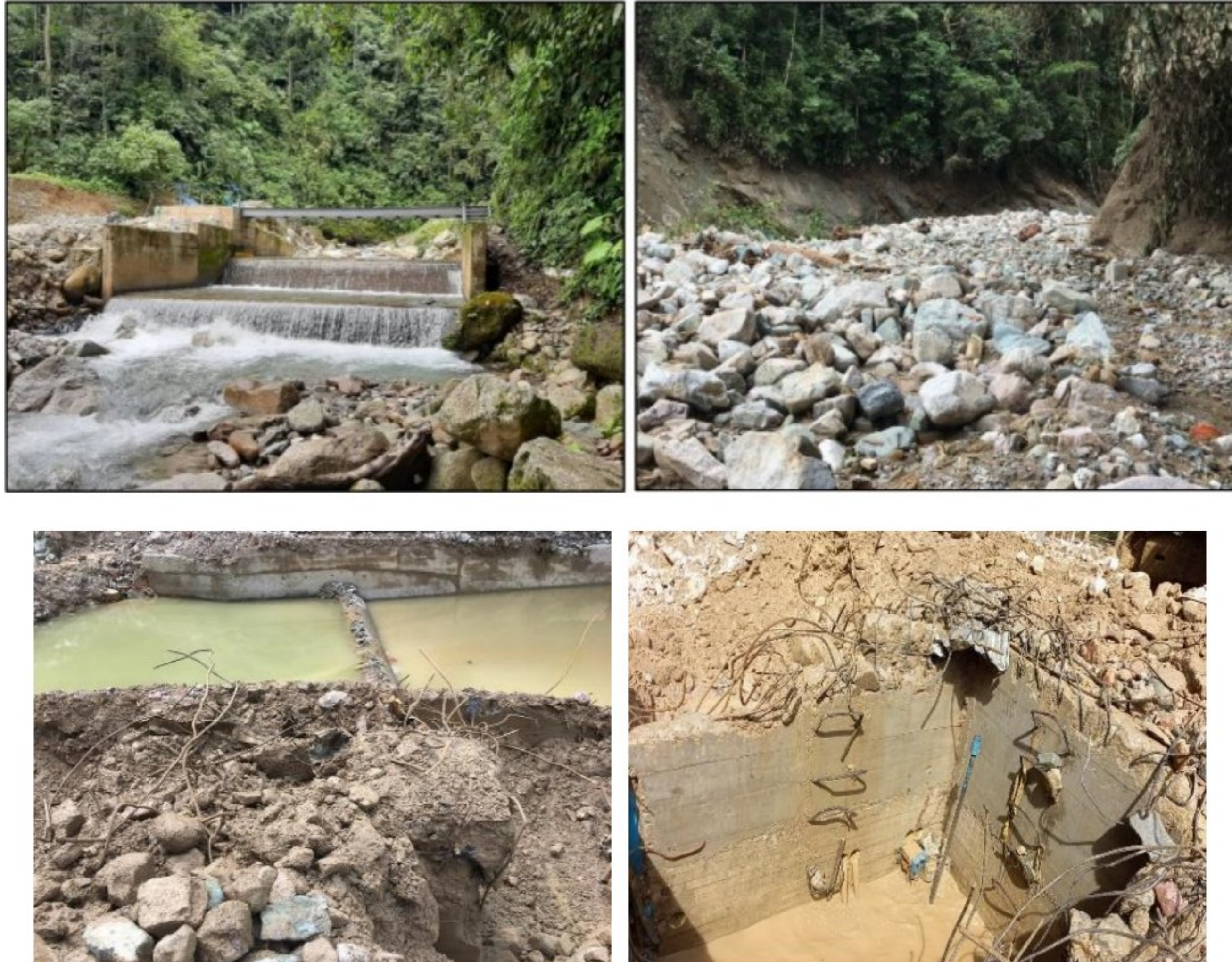
Fotografía 2. Destrucción Bocatoma Palmeras
